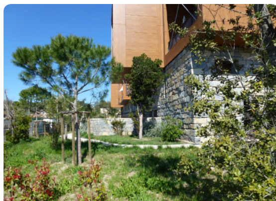
Écoquartier Viala-Est (Prades-le-Lez) : stationnement des véhicules en sous-sol des bâtiments.
